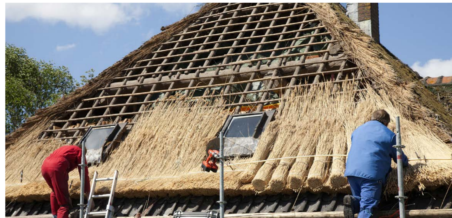
Isoleren van rieten daken volgens URL 4004
